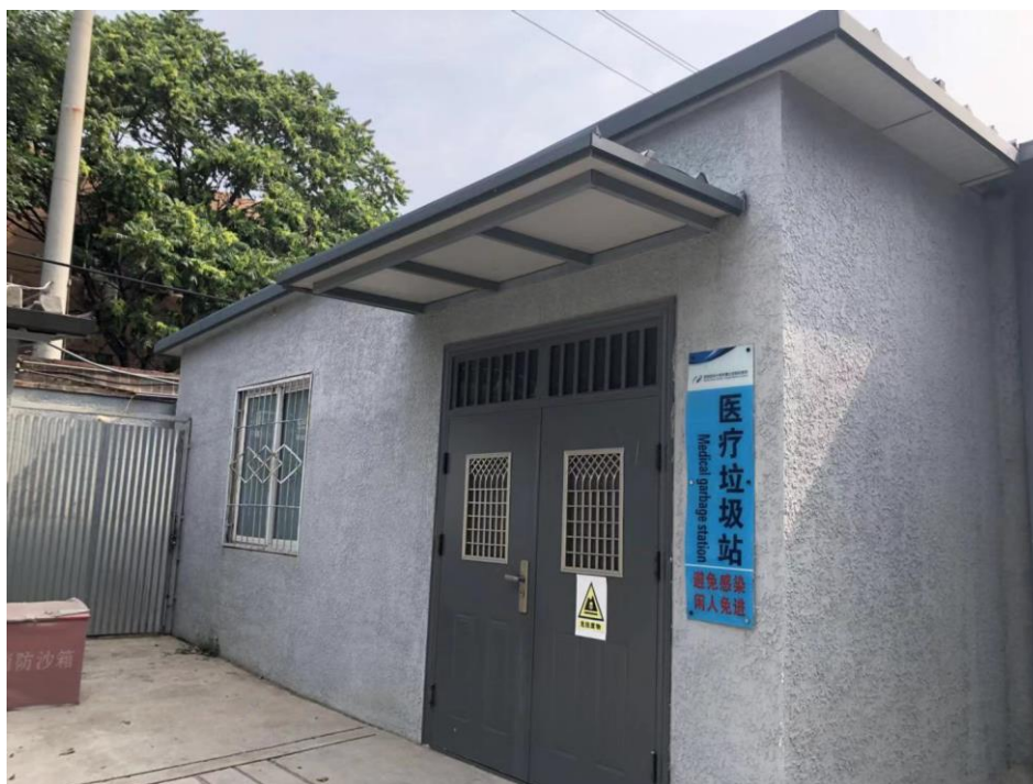
图 3.2-4 现状北京胸科医院医疗垃圾站
